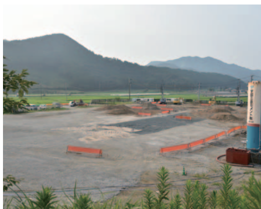
基礎工事が進む建設現場（8月19日）
